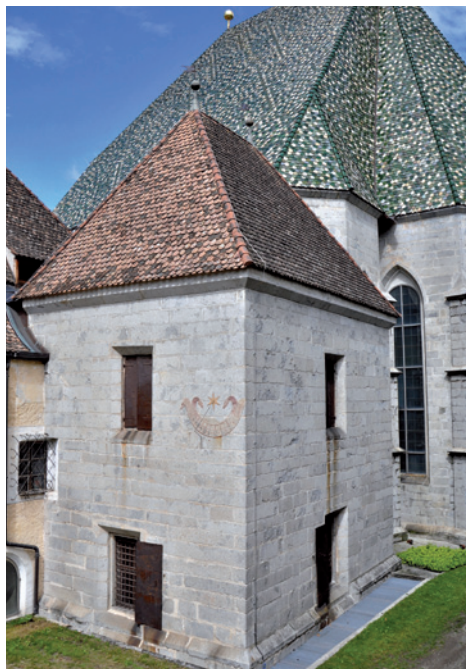
Um 1480 errichteter Sakristeizubau am Chor der Stiftskirche. Das Archiv im ersten Stock hat eiserne Läden, aber keine Glasfenster.
